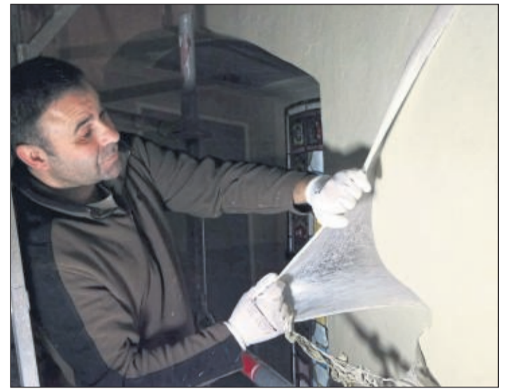
Wieder sauber: Die Rußpartikel bleiben im getrockneten Latex-Film, den Restaurator Colmenero gerade abzieht, hängen.
