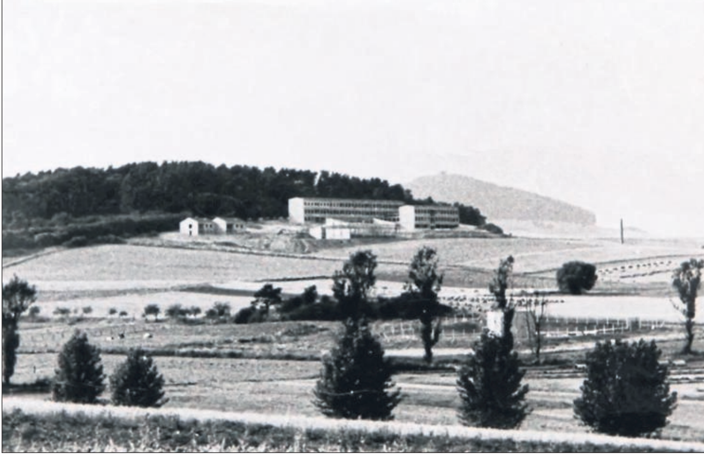
Ansicht aus der Schulchronik: Eines der ersten Fotos zeigt die Elbetalschule noch im Rohbau. Deutlich zu sehen sind die beiden parallel angeordneten Hauptgebäude, schräg davor die Turnhalle, links die Häuser für den Rektor und den Hausmeister. Die vorgelagerten landwirtschaftlichen Flächen sind heute mit Wohnhäusern bebaut.
