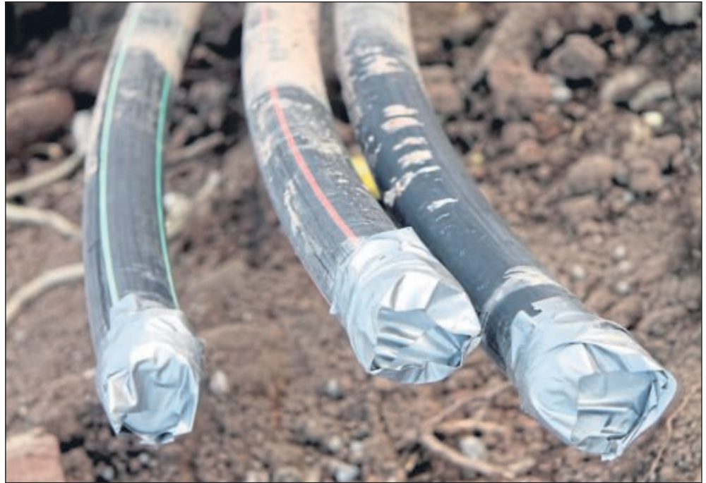
So sehen sie aus: Die Rohre, wie sie beim Breitbandausbau unterirdisch verlegt werden.
